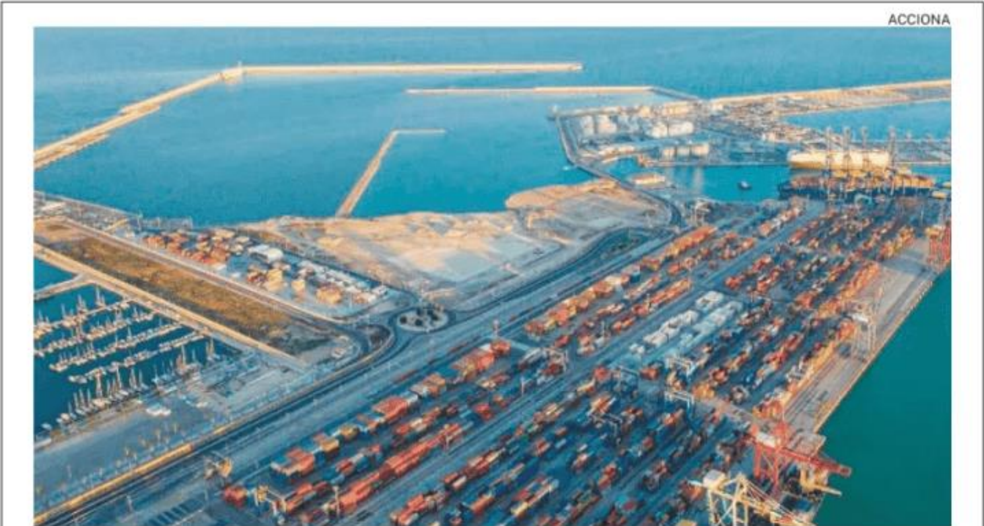
Obras de construcción de la terminal de contenedores para la ampliación del Puerto de Valencia
